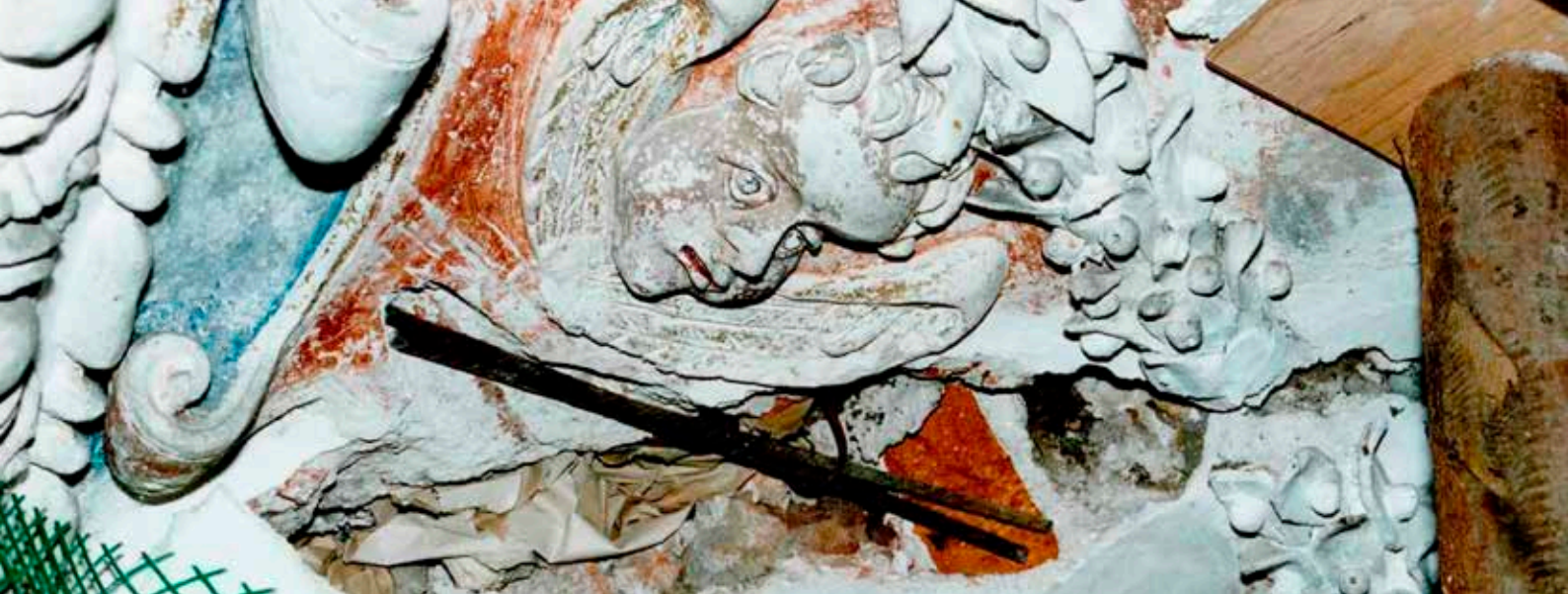
35. Klenby chrámu se štukovou výzdobou musely být podpírány a náročně vyztuženy ocelovými sponami 36. Štukový reliéf anděla na jižní straně klenby kostela před restaurováním
